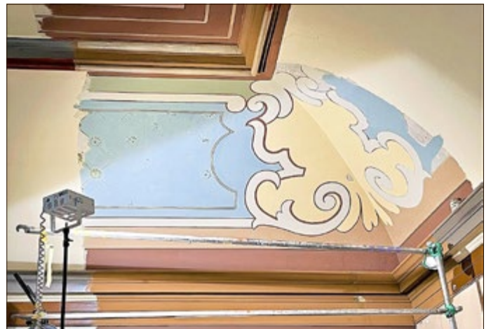
Die noch nicht ganz fertiggestellte „Musterfläche“ in der nordwestlichen Saalecke
